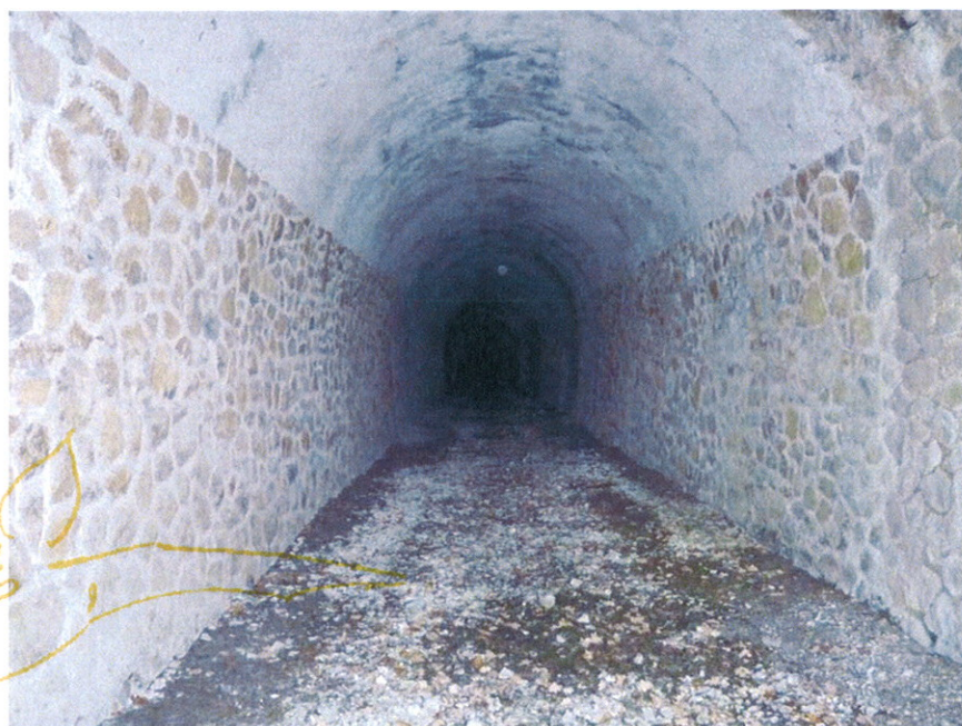
Tunnel du site de Sainte-Colombe © Julien Girard-Claudon
